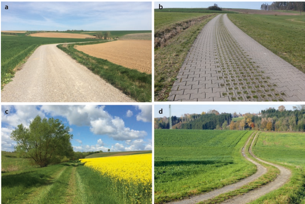
■ Abb. 6.24 Zu den Wegetypen, die sich günstiger auf den Wasserhaushalt auswirken als durchgehend asphaltierte Fahrbahnen, zählen Wege mit wassergebundener Tragdeckschicht (Schotterwege) (a), Pflaster spurwege (b) und Grünwege (c). Bei wenig befahrenen Schotterwegen (d) „begrünt“ sich der Mittelstreifen oft von selbst. Das Bild zeigt deutlich die Vernässung in der Hangmulde, die häufig als Begründung für eine Wegbefestigung genannt wird. Die Vernässung ließe sich einfach vermeiden, indem der Weg auf einem kleinen Damm geführt und hinter dem Damm ein Retentionsbecken geschaffen würde. (Bildquellen: a, b und c: Peter Pfarr, d: Karl Auerswald)
