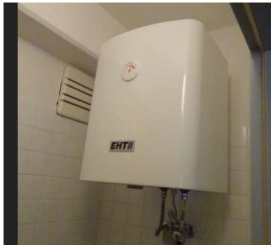
Abbildung 4: Untertischspeicher 5l in den Gruppenwaschräumen und Kleinspeicher in den Allgemeinräumen
