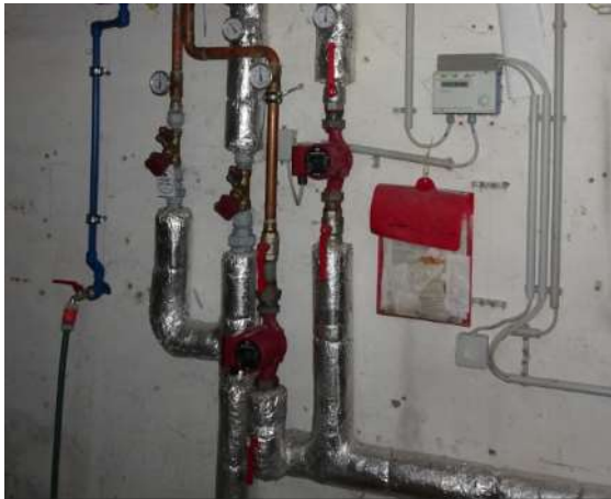
Abbildung 3: Heizkreise mit Pumpe 1 und Pumpe 2, Regler Siemens RVD120 (Prüfprotokolle der alten Kesselanlage entfernen)
