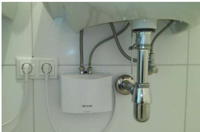
Abbildung 1: Durchlauferhitzer einphasig siehe z.B.: www.clage.de , www.stiebel-eltron.at
