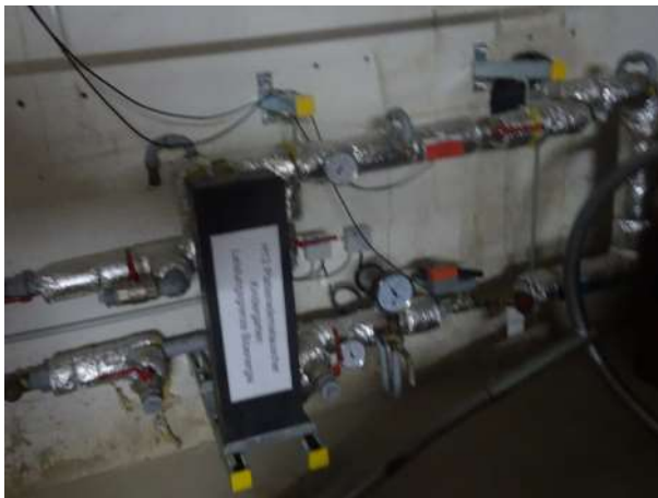
Abbildung 2: Wärmetauscher: Kein Wärmestromzähler, primärseitiges Regelventil wird vom Siemens
