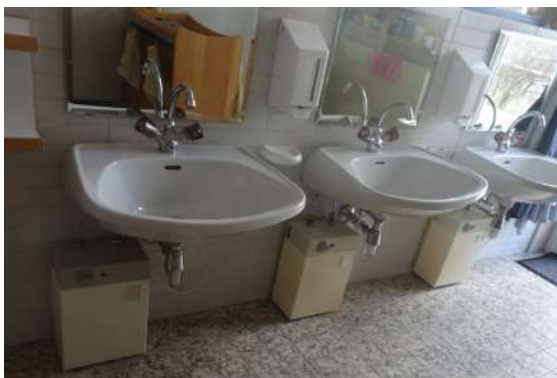
Abbildung 4: Untertischspeicher 5l in den Gruppenwaschräumen und Kleinspeicher in den Allgemeinräumen
