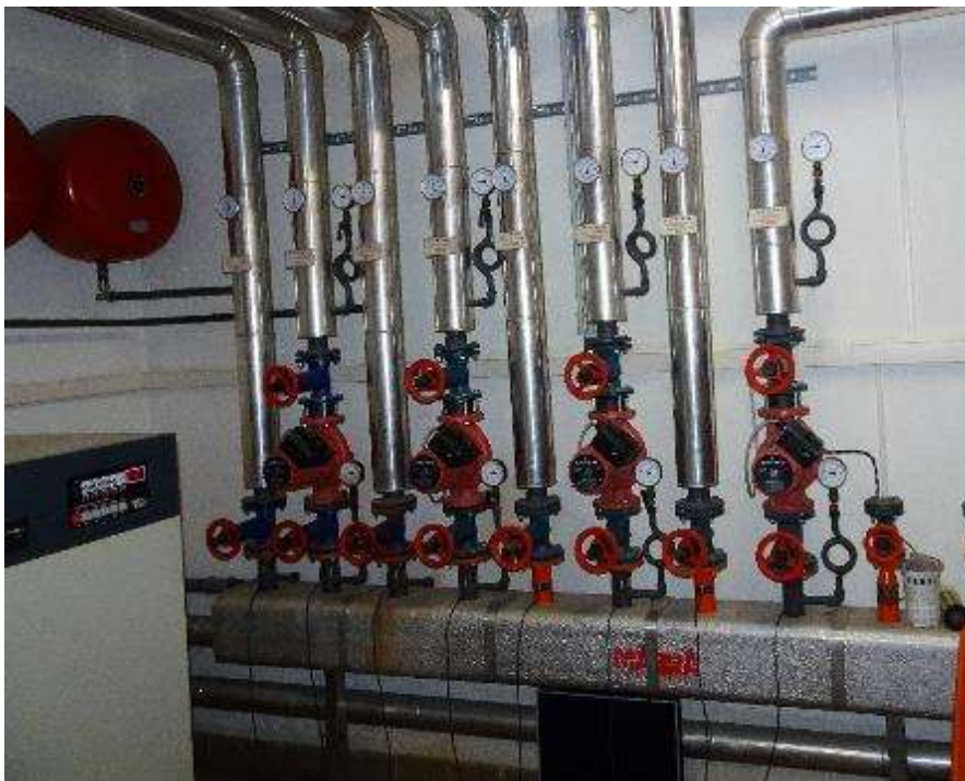
Abbildung 5: Heizungsverteiler (siehe Hydraulik-Skizze im Aufnahmeblatt) Pumpe: Drehstrompumpen Effizienzklasse E(?)
