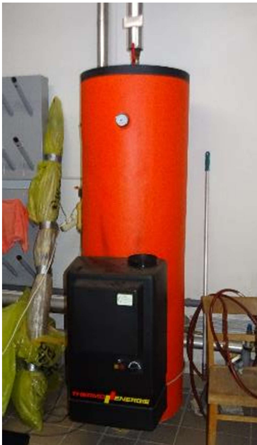
Abbildung 7: WW-Boiler mit Brauchwasser-Luftwärmepumpe Die Zirkulationspumpe ist links neben dem Boiler direkt ohne Zeitregelung angesteckt
