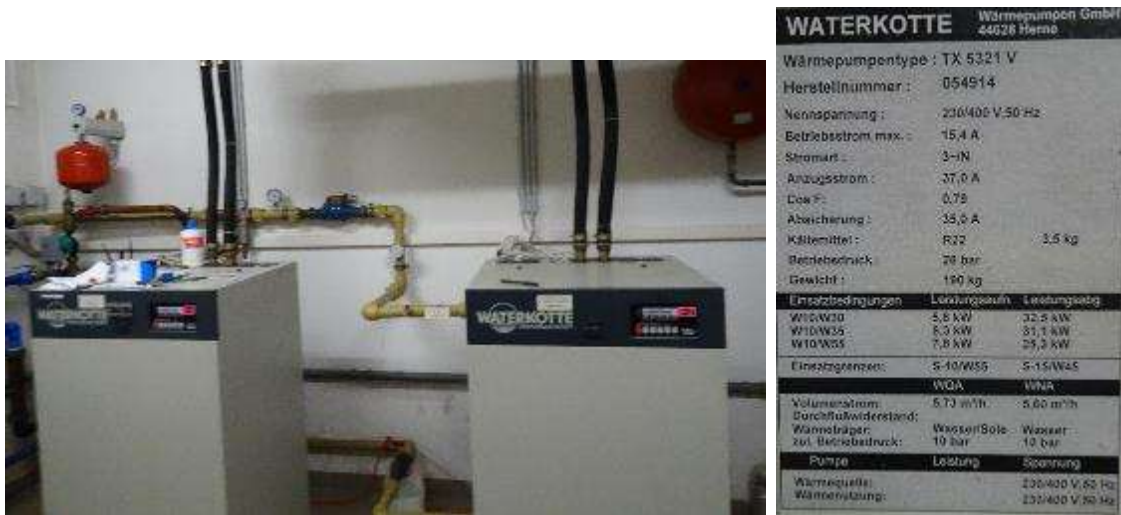
Abbildung 4: Heizungswärmepumpen, links ist der Grundwasseranschluss
