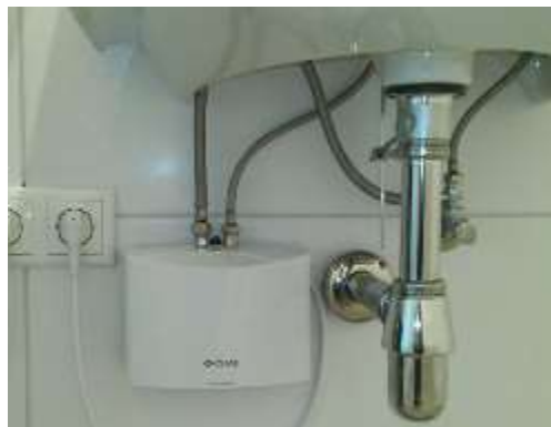
Abbildung 3: Für Handwaschbecken 1 phasig, für Duschen, Reinigung: 3 phasig mit mehr Leistung (auch Tandem möglich)
