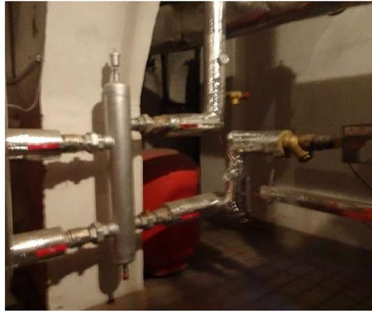
Abbildung 3: Hydraulische Weiche nach dem Kessel
