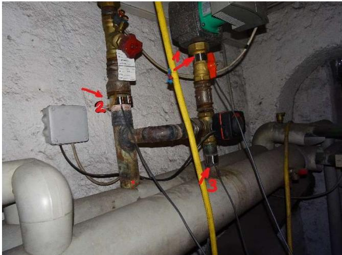
Abbildung 4: Abgang Schule Armaturen und Anschlussstücke nicht gedämmt
