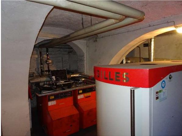
Abbildung 2: Hackgutkessel und stillgelegte Ölkessel
