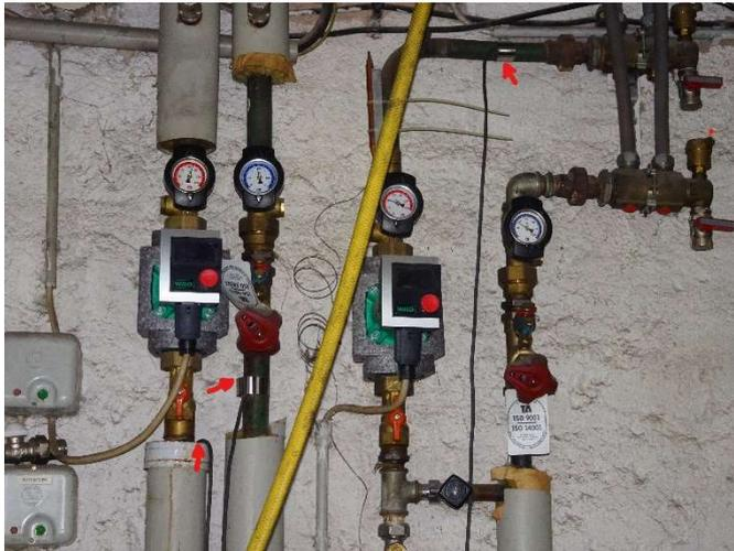
Abbildung 6: Abgänge EG und FBH, Hocheffizienzpumpen mit händischer Abschaltung (linker Bildrand), Fühler DL 1- 3
