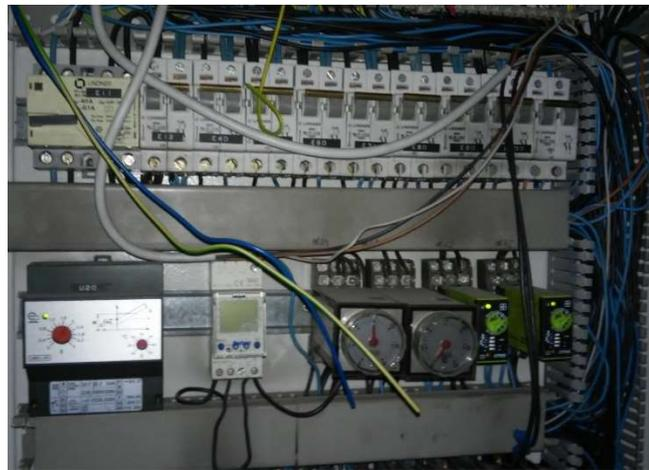
Abbildung 7: Schaltschrank links seitlich: Nachrüstung eines Heizkreises, Funktion Zeitschaltuhren? Elektr. Anlagenbuch?
