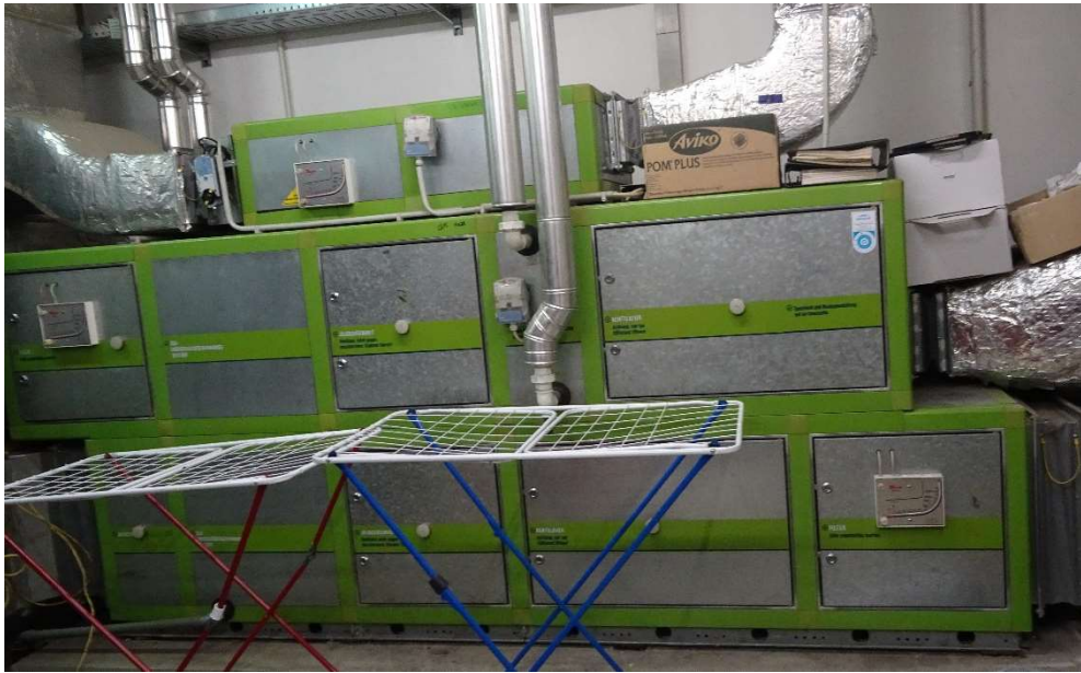
Abbildung 3: Turnhallenlüftung mit Nachheizregister
