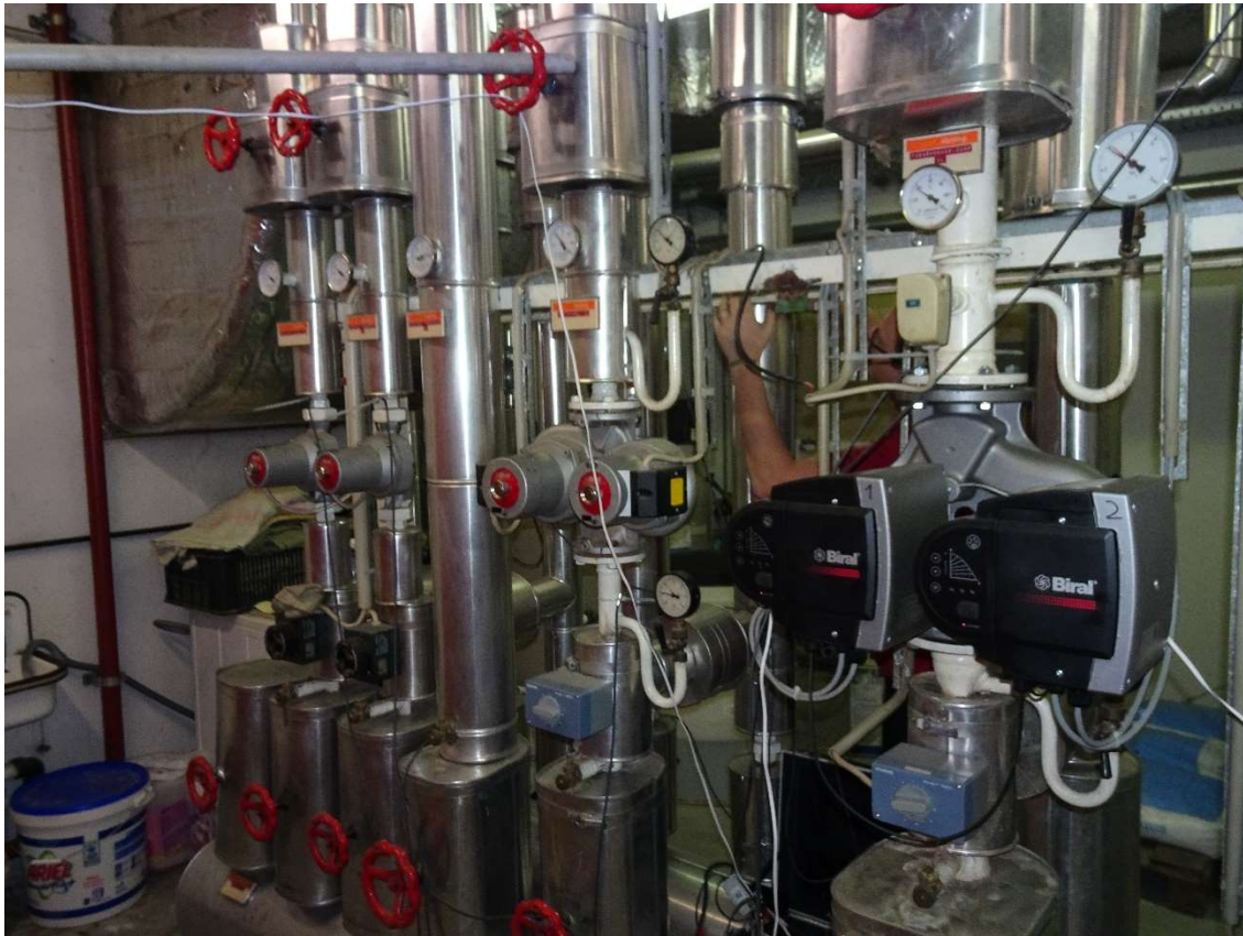
Abbildung 1: Teilansicht Verteiler Ausführung mit Doppelpumpen von links: Lüftung Sauna Lüftung Nebenräume, Lüftung Turnhalle Radiatoren, Fußbodenheizung
