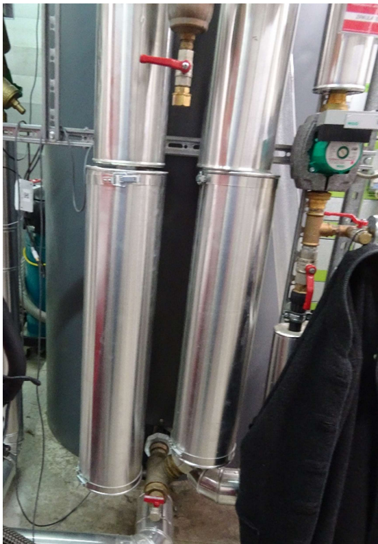
Abbildung 2: Warmwasserboiler 1500 l mit Zirkulationspumpe
