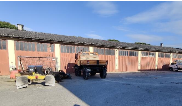
Abbildung 27: Bestandsgebäude des Bauhofs (Eigene Aufnahme 2023)
