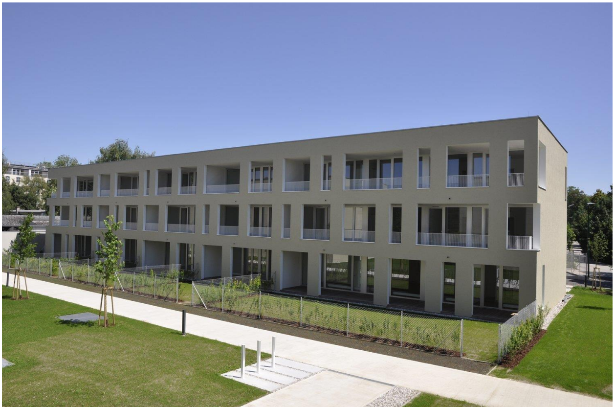
Abbildung 41: Beispielbild für die Bebauung des 3-geschossigen Wohnbaus (Quelle: https://www.hl-architekten.at/wp-content/uploads/2017/12/DSC0011.jpeg )
