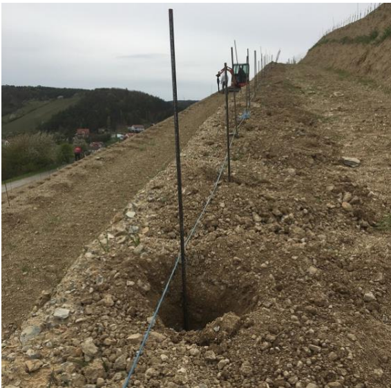
Abbildung 59: Die Querterrassierung während der Umgestaltung ( https://www.weingut-neder.de/weinbergsterrassierung/ )
