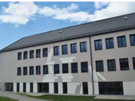
SCHULZENTRUM, RAINBACH IM MÜHLKREIS
