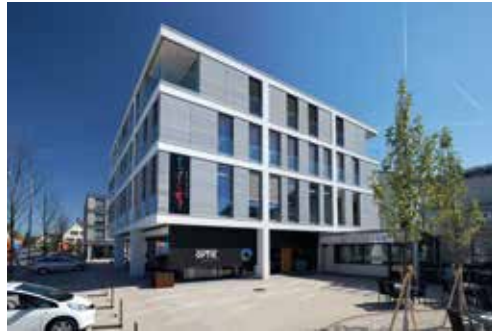
ATRIUM BAUTRÄGER GMBH, LAUTERACH
