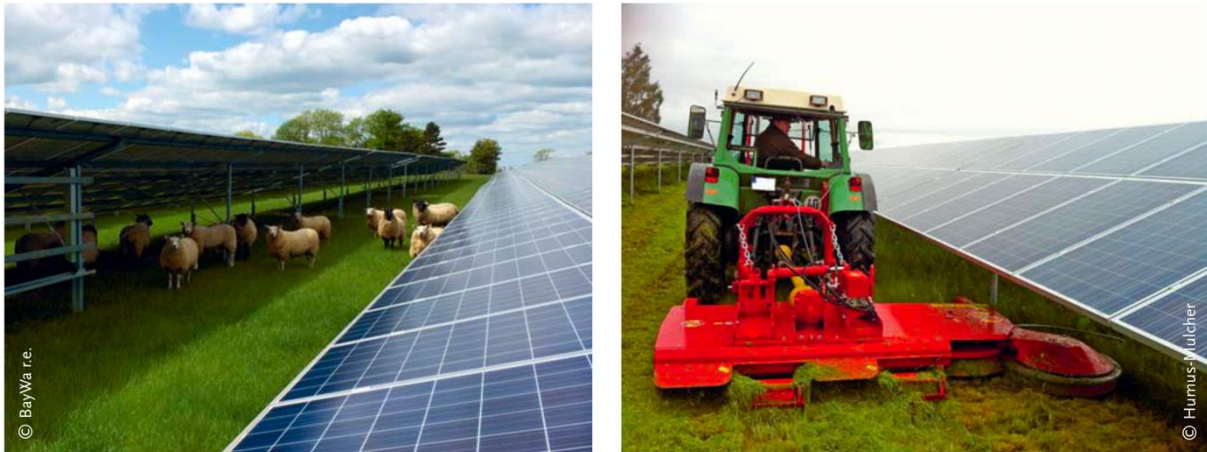
Abbildung 33: Bodennahe Freiflächen- Photovoltaik-Anlagen (PV-FFA) ermöglichen die Kombination aus Stromproduktion und extensiver landwirtschaftlicher Nutzung zwischen den Modulen
