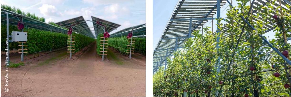
Abbildung 32: Die hochaufgeständerten Agri-PVA lassen eine Bewirtschaftung unter den Modulreihen zu und schützen vor Hagel-, Starkregen- und Dürreschäden
