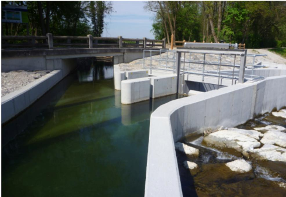
Abbildung 24 Sanierte Wolfswinkel Wehr mit Fischaufstieg<sup>34</sup>
