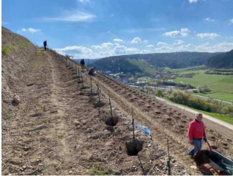
Abbildung 39: Neue Anlage einer Querterrassierung im Ramsthal 2021 ( https://www.weingut-neder.de/weinbergsterrassierung/ )
