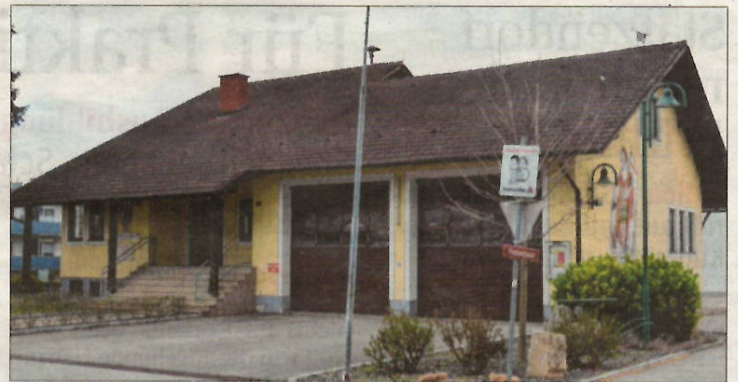
Auf das Dach des Feuerwehrhauses Reichersdorf kommt eine Photovoltaik-Anlage. Kostenpunkt: 20.668 Euro. Fotos: Günther Schwab
