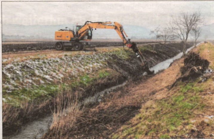
Ein Bagger entfernte einige Bäume, die ins Bachbett gepurzelt waren und den Wasserdurchfluss entsprechend behindert haben.
